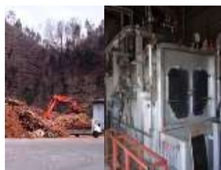
＜バイオマス発電所＞
