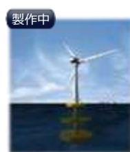
5MWダウンウィンド風車搭載 アドバンストスパー浮体 「ふくしま浜風」
